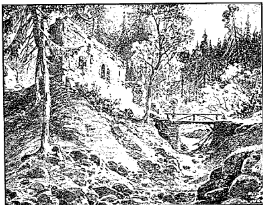
Obr. 4 - východní konec severního traktu Karlova Hrádku, pohled zvenčí (Sedláček, "Hradý"). V popředí hradního příkopu zbytky původně padacího mostu
