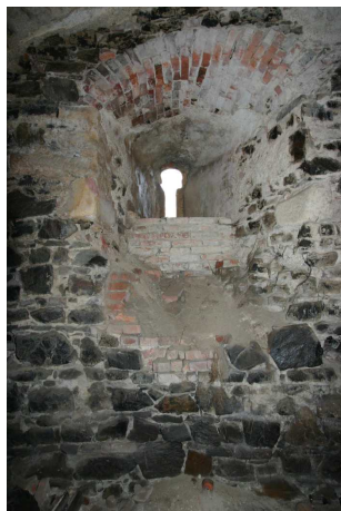
Švihov. Detail střílnové niky v přízemí Červené bašty na východní straně (foto 2011).
