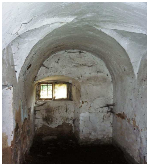
Košnice – západní místnost přízemí tvrze.
