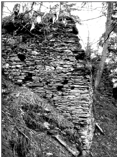
Obr. 4: Nístějka, opěrné pilíře paláce z jihu (foto autor).
