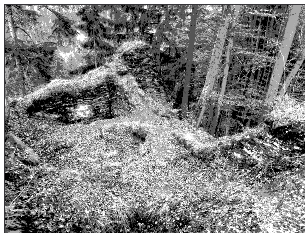
Obr. 6: Nístějka, pohled do paláce – na spodu je nevyužitý sklep a obvodní zdi paláce, vyšší místa v rozích jsou opěrné pilíře (foto autor).
