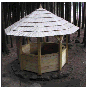
Nové roubení studny pod hradem.
