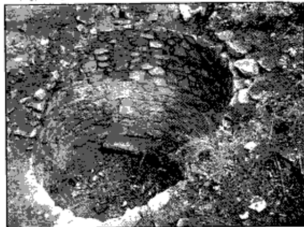
Hrad Křídlo, pohled do interiéru torza vstupní věže po dokončení sanačních prací (foto Vrla 2007).
