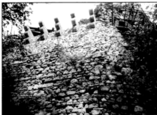
Obr. 1: Nový hrad u Adamova (okr. Blansko). Severozápadní hraděba, novodobé betonové krakorce, připravené pro výstavbu nového arkýře. Stav ve druhé polovině roku 2003, foto J. Štětina.
