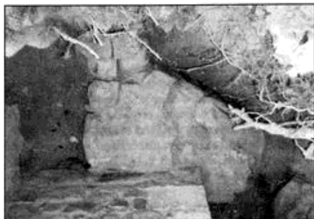
Nelechov - pohled na situaci přístavku při severozápadním nároží věže (půdorysně)
