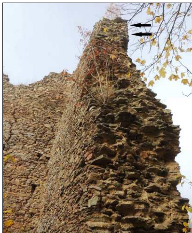
Obr. 3: Špaleta okenního (či jiného) otvoru (označeno šipkami) v úrovni čtvrtého podlaží severní zdi donjonu (foto a úprava autor 2016).
