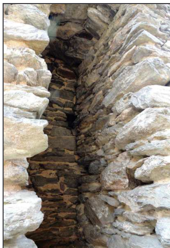
Obr. 9: Zazdívkou jižní části původního vstupu s dutým prostorem. Tato stavební úprava byla z důvodu statického zajištění jihozápadního nároží provedena koncem 19. stol. (foto autor 2016).
