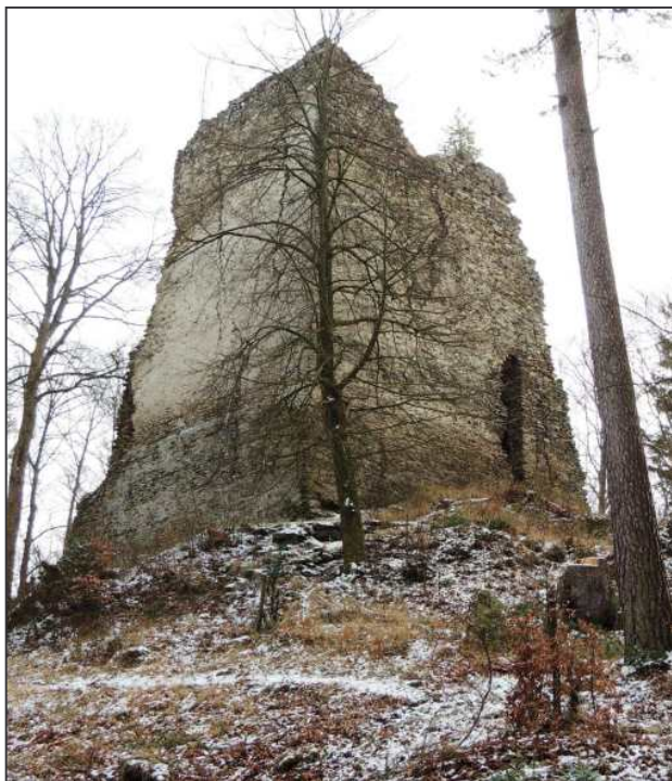
Obr. 4: Severní stěna donjonu s omítnutou plochou (foto autor 2016).
