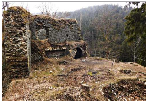
Navarov. Zbytek paláce od východu. Severní strana napravo je zcela bez zástavby (foto P. Špráchal 2016).
