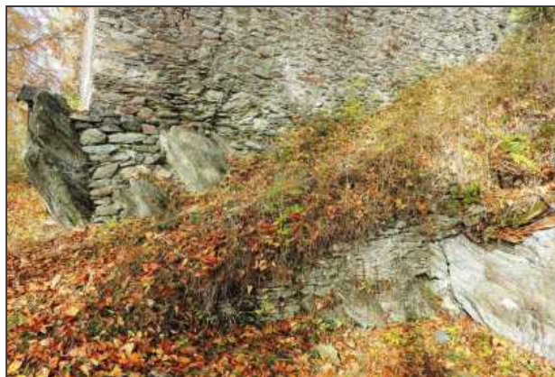
Obr. 6: Uložení základu jihovýchodního nároží do skalního výchozu (foto autor 2016).
