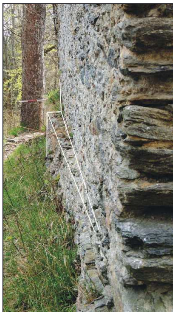
Obr. 2: Odsazení základového zdiva na severní straně donjonu (foto a úprava autor 2016).
