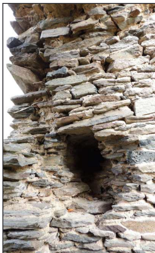
Obr. 10: Pozůstatek čtvercové kapsy v šířce zdi (o rozměrech cca 0,25 x 0,25 m) po zajišťovací dveřní závoře původního vstupu (foto autor 2016).
