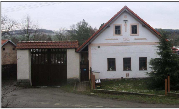
Střížovice čp. 18 – průčelí bývalé rychty s bránou (foto autor 2016).
