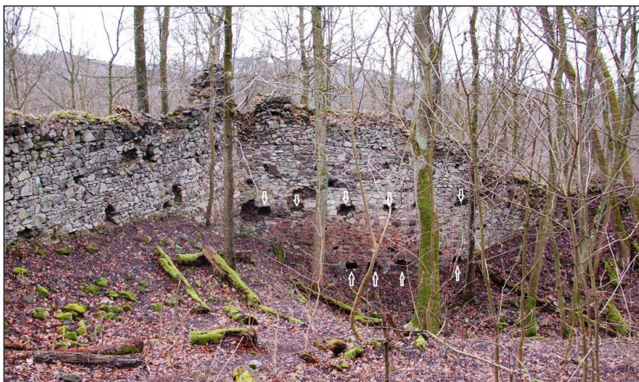
Otvory pro osazení stropních trámů dvoupodlažního objektu, vylámané do jihovýchodní nádvoří části obvodové hradby (označeno šipkami), který byl k této hradbě přiložen počátkem 16. stol. Pohled od jižní stěny donjonu.
