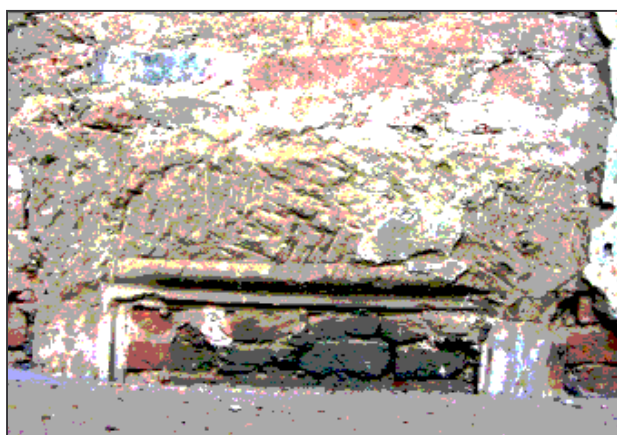
Obr. 4: Lešná (okr. Vsetín), zbytek okenního ostění z počátku 16. stol. ve dvorním průčelí severovýchodního křídla zámku. Po polovině 17. stol. okno překryla podlaha nádvorní arkády.
