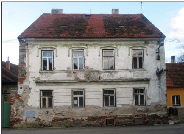
Návesní fasáda Dolního dvora čp. 40 (foto P. Rožmberský 2015).
