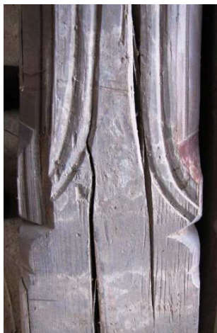
Obr. 7: Lešná (okr. Vsetín), detail profilace stropního trámu z místnosti ve východním nároží přízemí. Stropní trámy byly vytesány z jedlí, pokácených v letech 1658-1659; stav před restaurováním.
