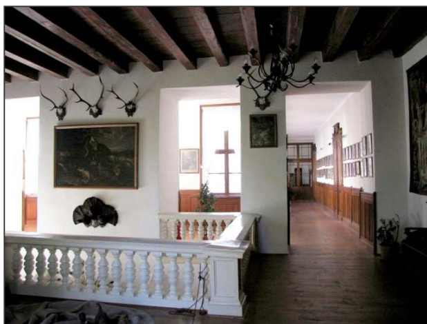
Obr. 6: Lešná (okr. Vsetín), schodišťová hala v patře severozápadního křídla si uchovala prostý trámový strop, dendrodatovaný do let 1633/34. Další zajímavostí je zábradlí schodiště, včetně kuželek vyrobené z plechu. Vpravo průhled do okružní chodby někdejší dvorní arkády.
