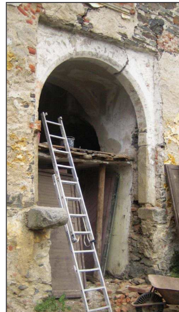
Vybourávání zazdívký brány tvrze v Dolanech (foto Z. Procházka 2015).
