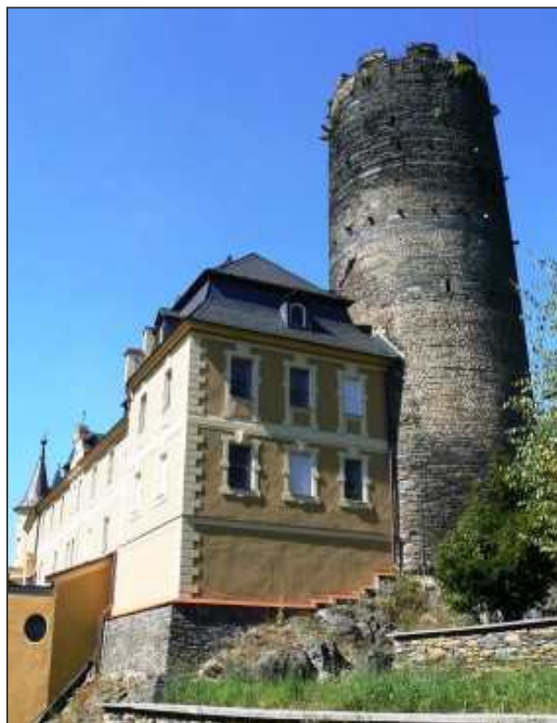
Zámek/hrad Starý Hrožňatov, stav po rekonstrukci (foto autor květen 2013).
