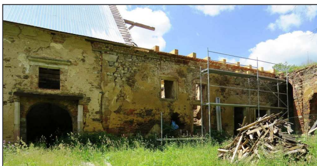
Toužimský zámek v rekonstrukci.
