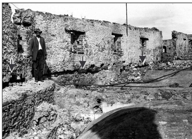
Obr. 6: Hrad Buchlov, historický snímek z doby po požáru střech jádra v r. 1931, severozápadní část vnější zdi severního traktu, pohled od jihozápadu (napravo zřícený vstup do prostoru nad hranolovým rizalitem); šipky vyznačují úroveň dřevěných prvků, zmíněných v textu (fotoarchív NPÚ).
