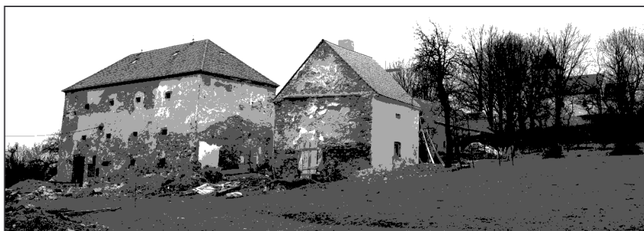
Tvrz Řesanice. Objekt sýpky a černé kuchyně před rekonstrukcí, v pozadí raně gotický kostel Věch Svatých. Foto J. Vladař (2004).
