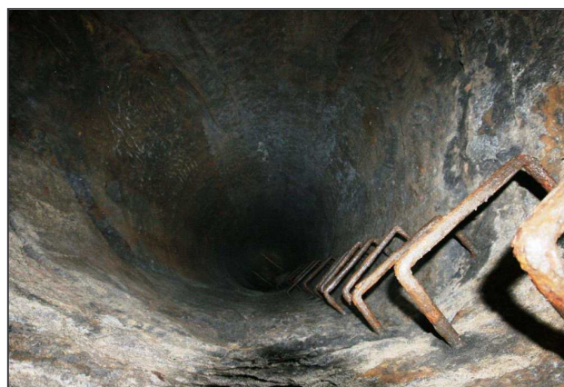
Tubus studny se stupačkami, které tam měla umístit německá armáda.
