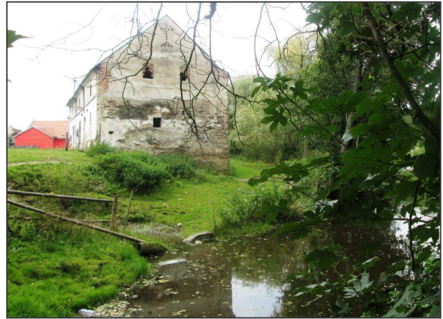
Pohled na tvrziště v Úněšově z hráze rybníka.
