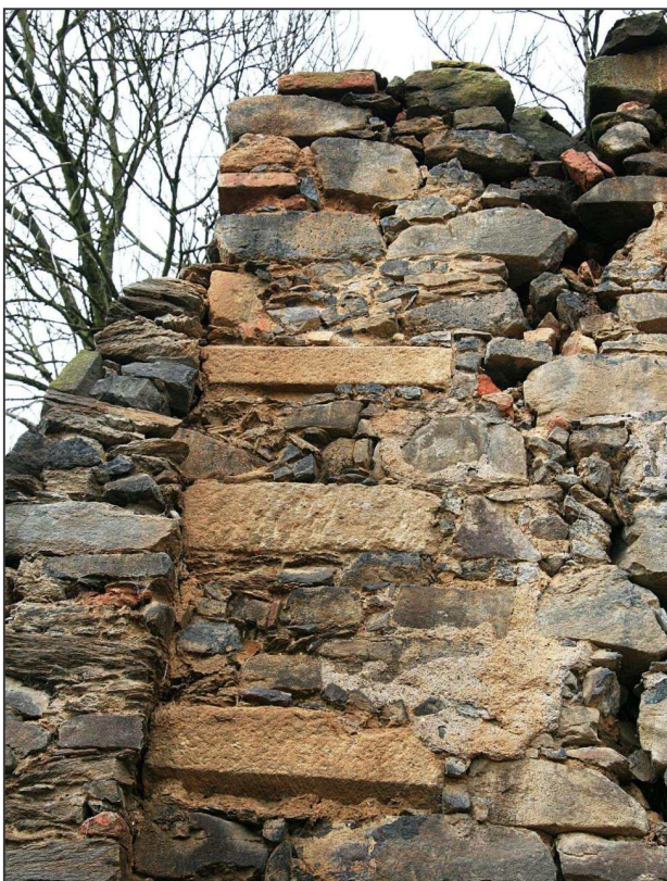
Obr. 7: Týniště, druhotně použité gotické ostění v jihozápadním nároží jižního křídla dvora (foto L. Krčmář 2008).
