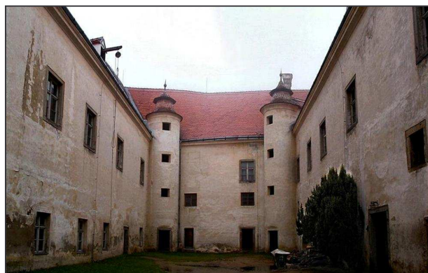
Sádek – západní část nádvoří se schodišťovými věžemi, mezi nimiž je zazděn raně gotický donjon (foto P. Zany Komárek 2002).
