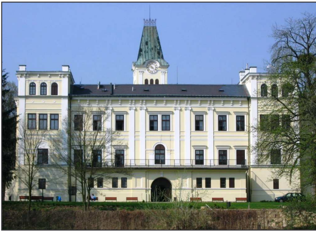
Obr. 2. Východní průčelí, jehož středem prochází průjezd – původní vstup do hradu. Nárožní nástavby jsou výsledkem přestaveb 19. století, ani jihovýchodní blok (vlevo) tedy neobsahuje konstrukce dříve předpokládané hranolové věže.
