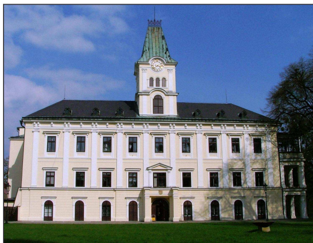
Obr. 1. Kvasice (okr. Kroměříž), zámek. Pohled na západní, dnes vstupní průčelí nenaznačuje vysokou míru dochování středověkých konstrukcí v organismu současného zámku (všechny kresby a fotografie autor 2005-2012).
