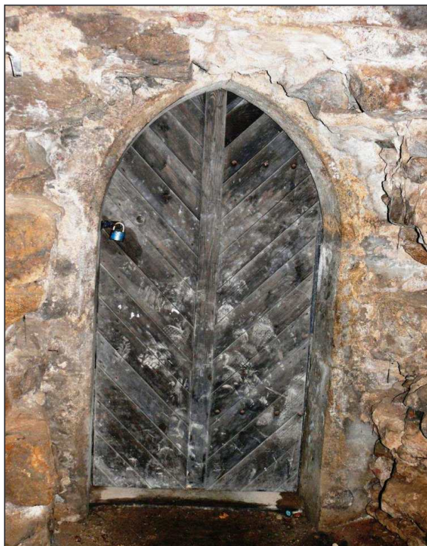
Vnitřní portál výpadní branky ze spodního podlaží věže Samson.
