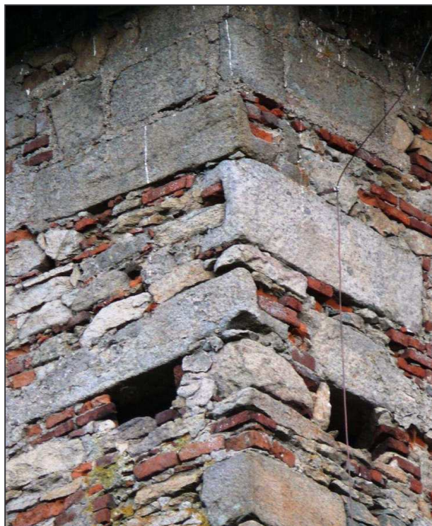
Kamenné žlaby druhotně použité jako armatury pod korunou severozápadního nároží Thurnovského paláce.
