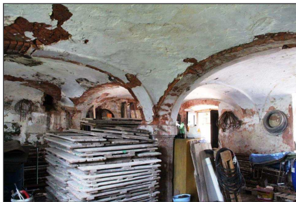
Čistá, přízemí západního křídla (foto O. Slabý 2013).
