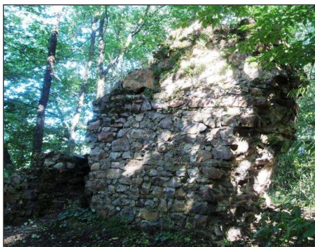
Ejpovický hrádek, torzo západní zdi – exteriér (foto autor 2013).
