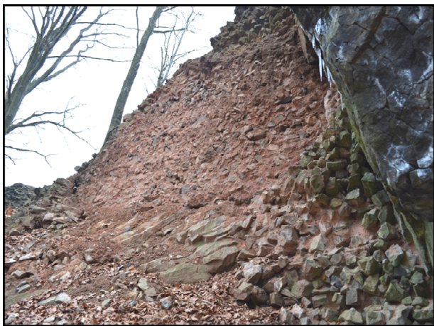
Hrad Bradlec – jižní skalka – jizva po zřícení mladšího zesílení (foto T. Šimůnek 31. 12. 2012).
