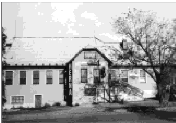
Restaurace ve Zlatníkách na místě tvrze. Pohled od západu (foto J. Synek 2008).
