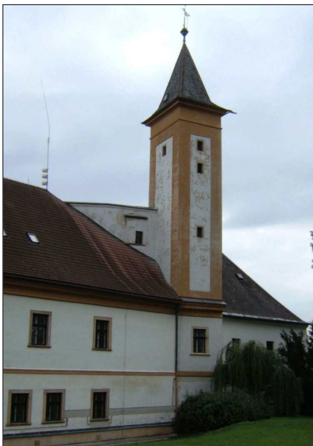
Obr. 8: Pozdně gotická, renesančně zvýšená hranolová věžice v severovýchodním obvodu hradby. Vlevo navazuje barokní zámecká budova, nad jejíž střechou je patrná vnější zeď renesanční chodby s pravoúhlým ostěním.
