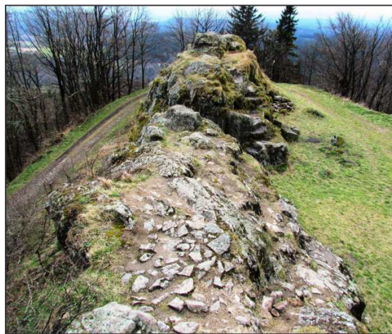
Obr. 4: Přimda, zřícenina hradu. Pohled na skalní hřeben od severu. Vpředu torzo zdiva, při pravém ústí brány ve skále patrné schody.
