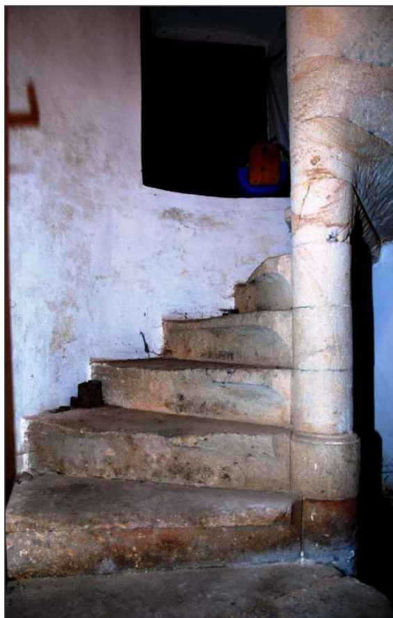
Obr. 8: Hunčice, residence, renesanční šnekové schodiště do bývalého 1. patra.
