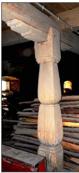
Obr. 5: Hunčice, poplužní dvůr, sýpka, barokní dřevěná konstrukce.
