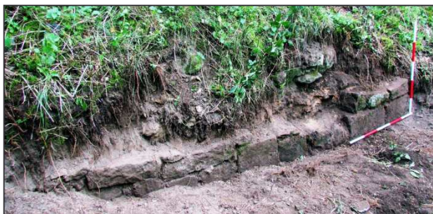
Obr. 12: Přimda, zřícenina hradu. Torzo zdiva s kvádrovým lícem a zachovaným nárožím pod západním okrajem dnešního nádvoří. Pohled od severozápadu.
