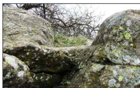
Obr. 9: Přimda, zřícenina hradu. Jižní žlab na temeni severní části skalního hřebenu, západní ústí.
