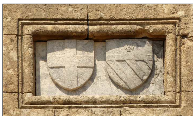
Archangelos, detail johanitského a Orsiniho erbu na opevnění.
