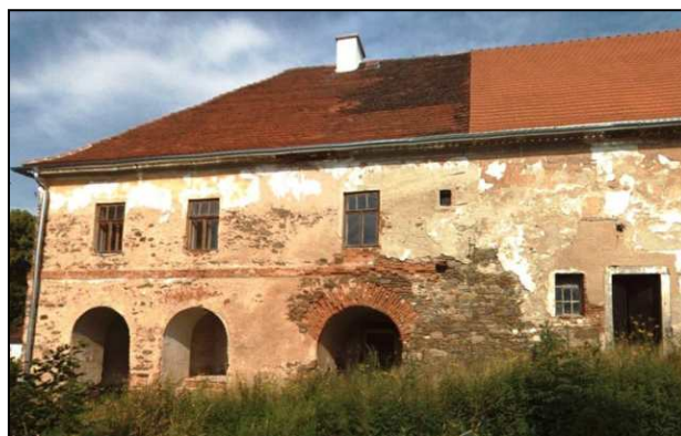
Jižní část západního objektu bývalého němčického poplužního dvora v roce 2015 ( https://mapy.cz – Panorama).
