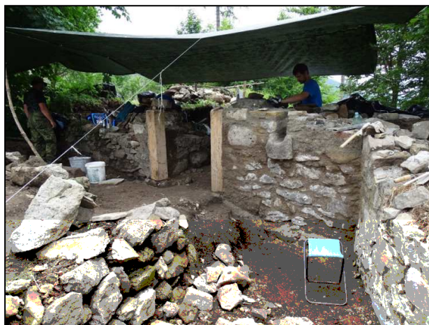
Obr. 2: Nový Šaumburk, pohled na severní část nádvořního průčelí budovy v průběhu konzervačních prací; vpravo znovu osazená výlevka, uprostřed torzo vstupu do místnosti. Do jizev po vytrženém ostění byly vsazeny dubové trámký (R. Vrla 2021)
