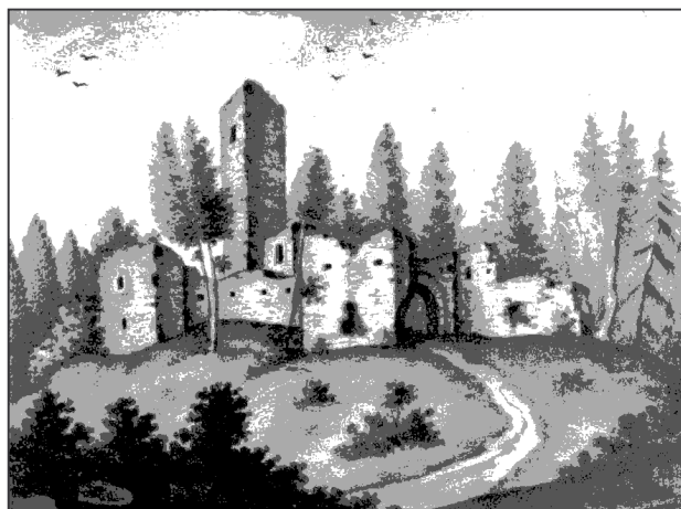
Pohled na hrad Orlik z r. 1803 (kresba A. Pařízek). Znázorňuje budovu vlevo od brány, přičemž tmavý pravý okraj zdiva s výrazným poškozením v přízemní části a detailem předstupujícího reliktu zdiva je zřejmě pozůstatkem první brány.
