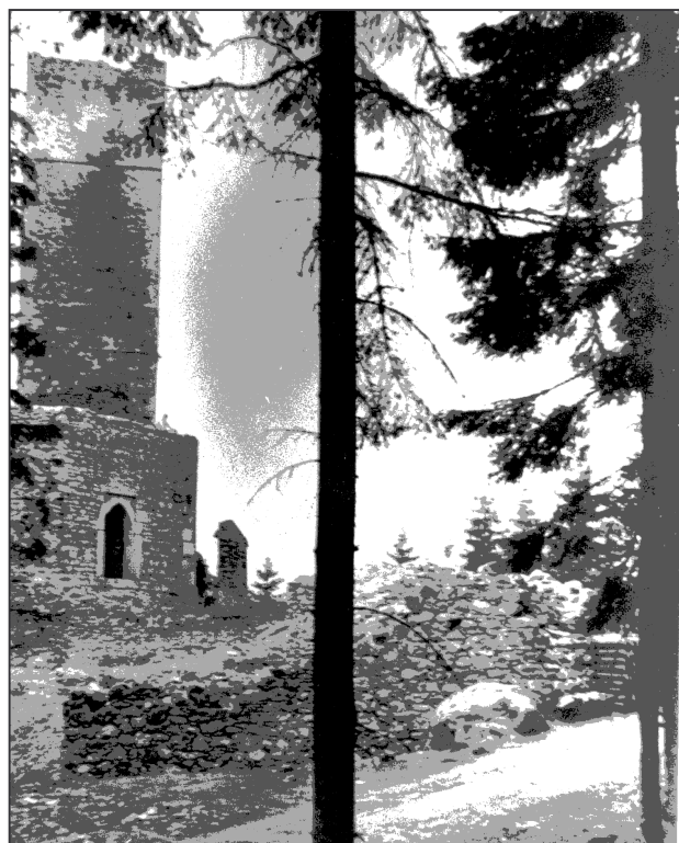
Stav reliktů zdiva budovy u brány po zajištění zdiva v r. 1941.
