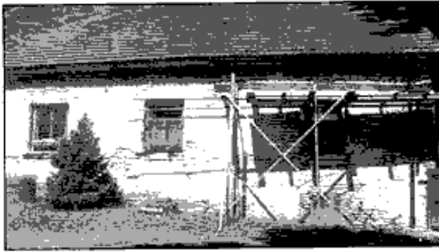
Panské sídlo v Podhůří, pohled z nádvoří (foto J. Anderle 2004)
