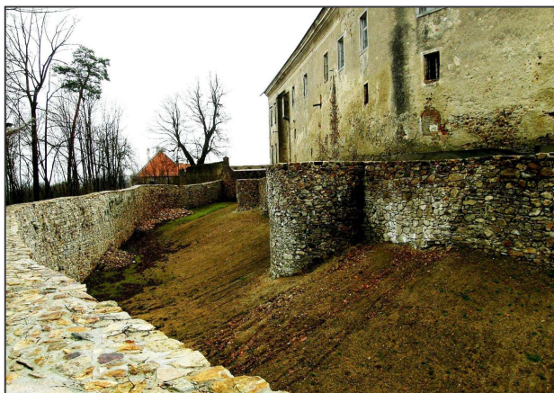
Severní okružní příkop s parkánovou a kontreskarpovou zdi (foto autor 2014).
