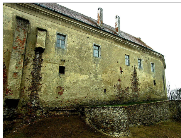
Pohled na vnější líc severního zámeckého křídla, který v sobě skrývá nejstarší stavební aktivity včetně pozůstatků valdštejnského paláce z doby husitské. Obvodová hradba gotického hradu se zalamovala v pravém úhlu k bergfritu mezi oběma patrnými prevěty (foto autor 2014).
