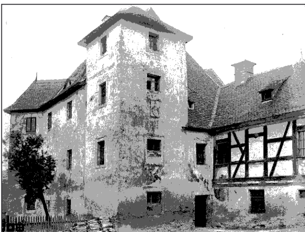
Obr. 6. Horní Hradičná, schodišťová věž a vstup do zámku (foto A. John 1892).
