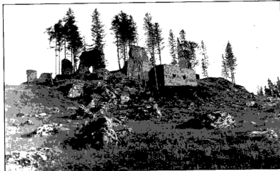
Orlík u Humpolce, pohled na hrad od severozápadu (foto těsně po r. 1907)
