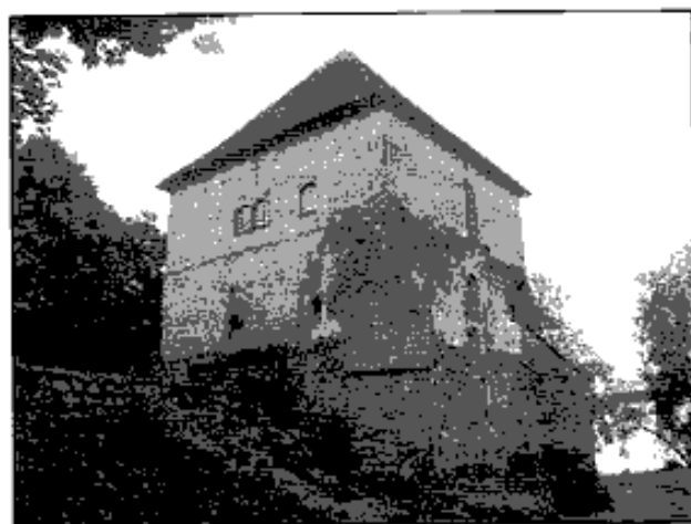
Trakai, jižní nárožní věž staršího hradu na poloostrově (foto P. Sokol)
