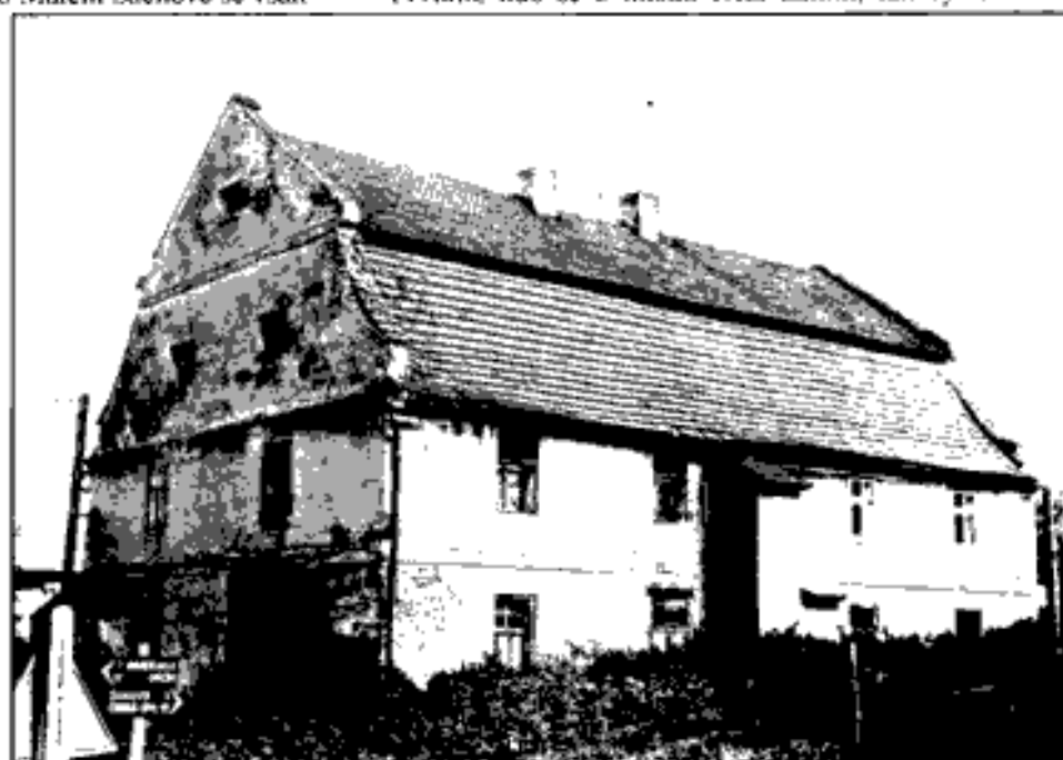
Obr. 3: Malý Šachov, pohled na tvrz od západu. Stav roku 1975, foto P. Fiedler
