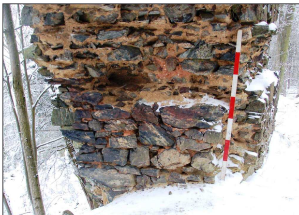
Obr. 6: Netřeb (okr. Domažlice) – okenní špaleta v západní obvodové zdi v úrovni prvního podlaží (foto autor 2017).
