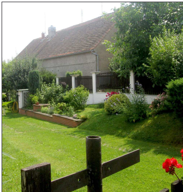
Pohled na severozápadní nároží domu čp. 1 ve Lhotce na místě záměčku. Je patrné, že stojí na vyvýšeném terénu (foto autor 2016).
