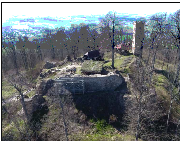
Obr. 1: Rýzmberk – pohled od jihovýchodu, v popředí pozůstatky tzv. starého paláce (foto z dronu T. Mařík 2021).
