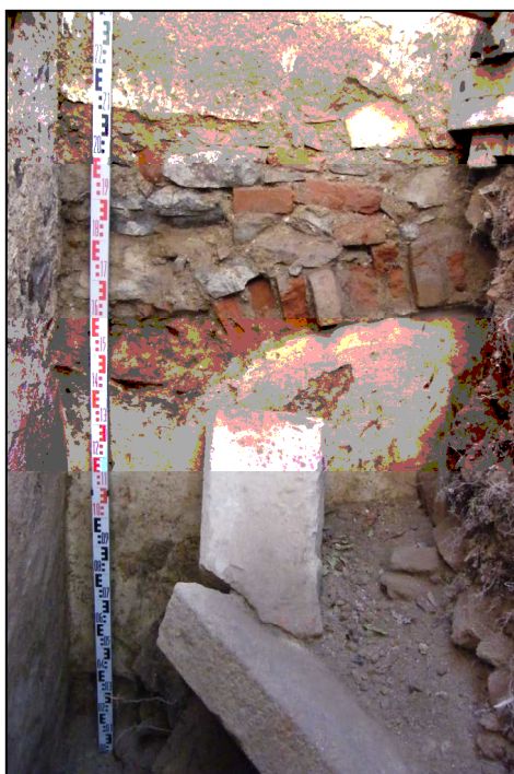
Obr. 6: Rýzmburk – situace odhalená sondou při nádvořní zdi tzv. starého paláce. K vidění je zde příčka patrně renesanční přístavby s interiérovou omítkou, zbytkem cihelné klenby, otiskem podlahy a přelomeným architektonickým článkem s jednoduchou profilací – pohled od severovýchodu (foto P. Kausek 2011).
