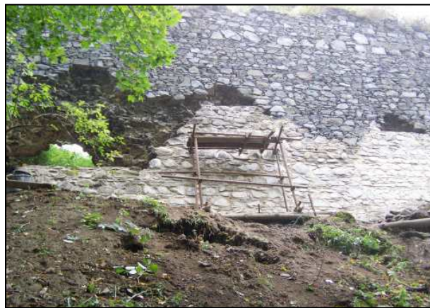
Oprava průvalu hradeb (foto J. Ptáček).
