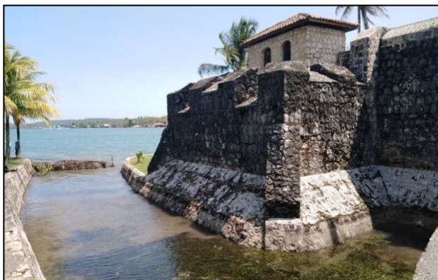
San Felipe – bastion u vstupu (foto P. Mikota 2019).
