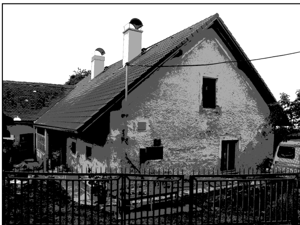
Zuklín – bývalý barokní zámek, nádvorní a štítová zeď (foto Š. Morávka 2019).
